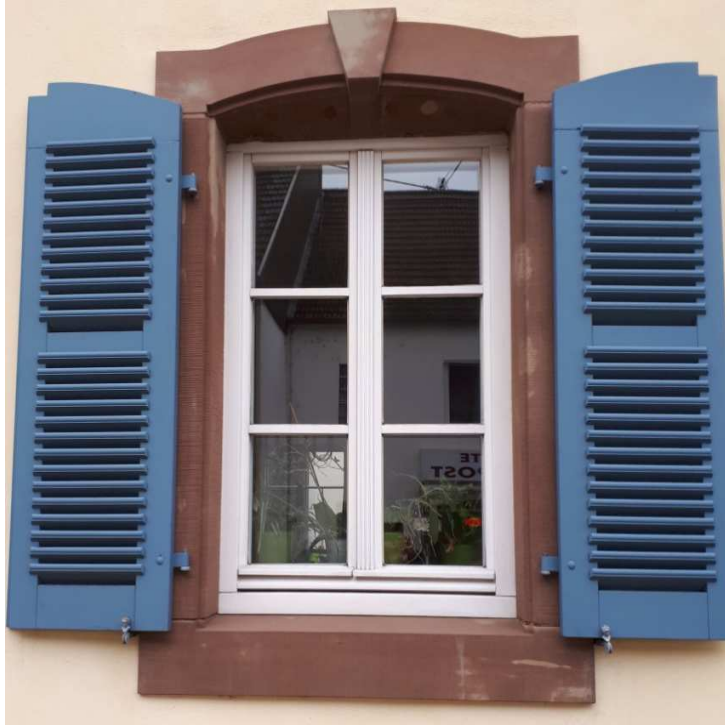
Elsässer Straße 40 u. 42 Baujahr 1740,
