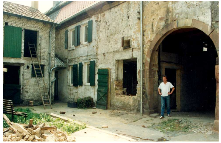
Elsässer Straße 40 u. 42 Baujahr 1740, Foto von 1991 während der Renovierung, Innenhofbereich mit ehemaligen Stallungen.
