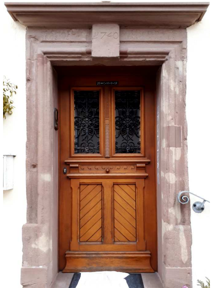
Elsässer Straße 40 u. 42 Baujahr 1740,
