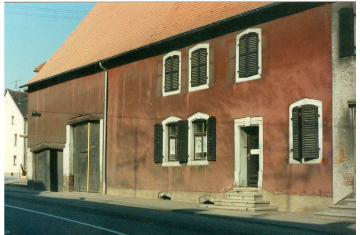
Elsässer Straße 40, 1990 vor der Renovierung; Auf diesem Bild ist zu erkennen, dass die Fenster im Erd- u. Obergeschoss neben der Scheune irgendwann zugemauert wurden (siehe Foto v. 1946). Foto: Monika Dieudonné
