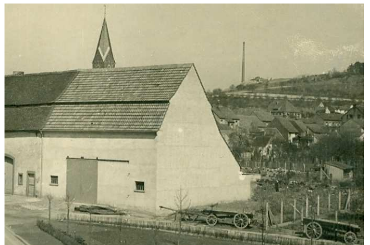
Die renovierte Scheune Degott um 1946
