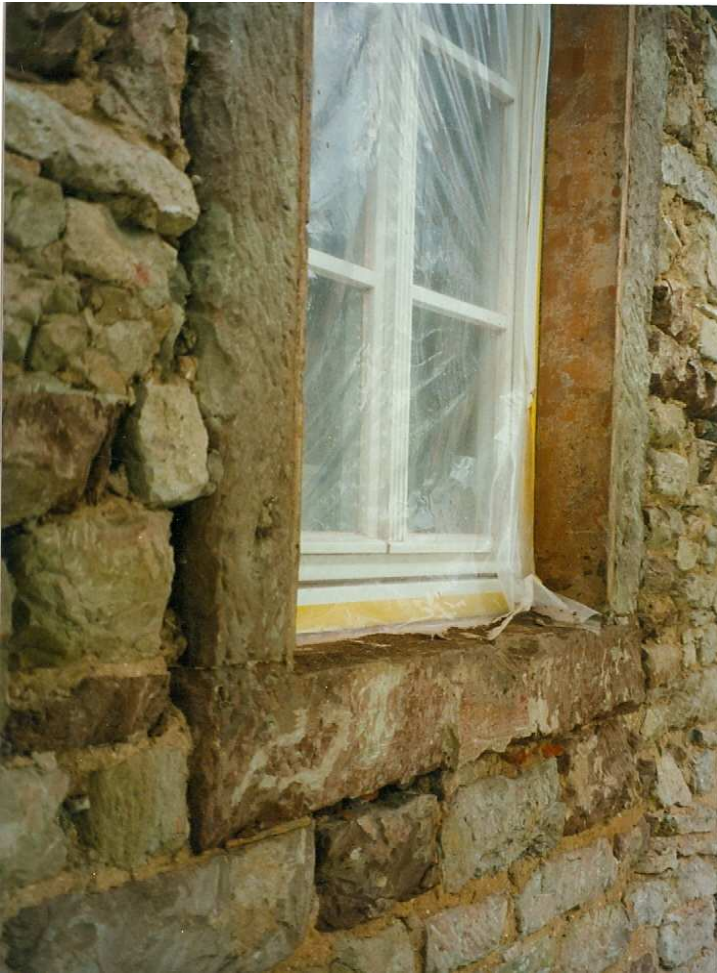
Entfernung des vorhandenen Putzes Foto: Monika Dieudonné
