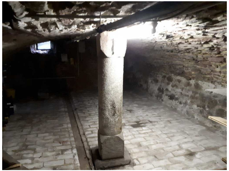
Kellerraum mit Mittelpfeiler aus dem Jahre 1740
