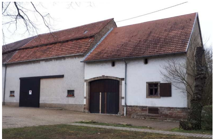
1947 ließ Josef Degott neben die Scheune der Familie Kihl eine neue Scheune bauen.
