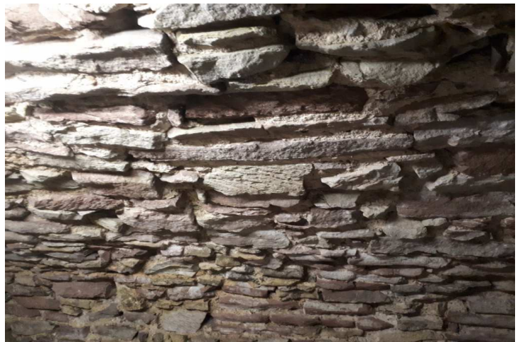
Kellergewölbe aus dem Jahre 1740
