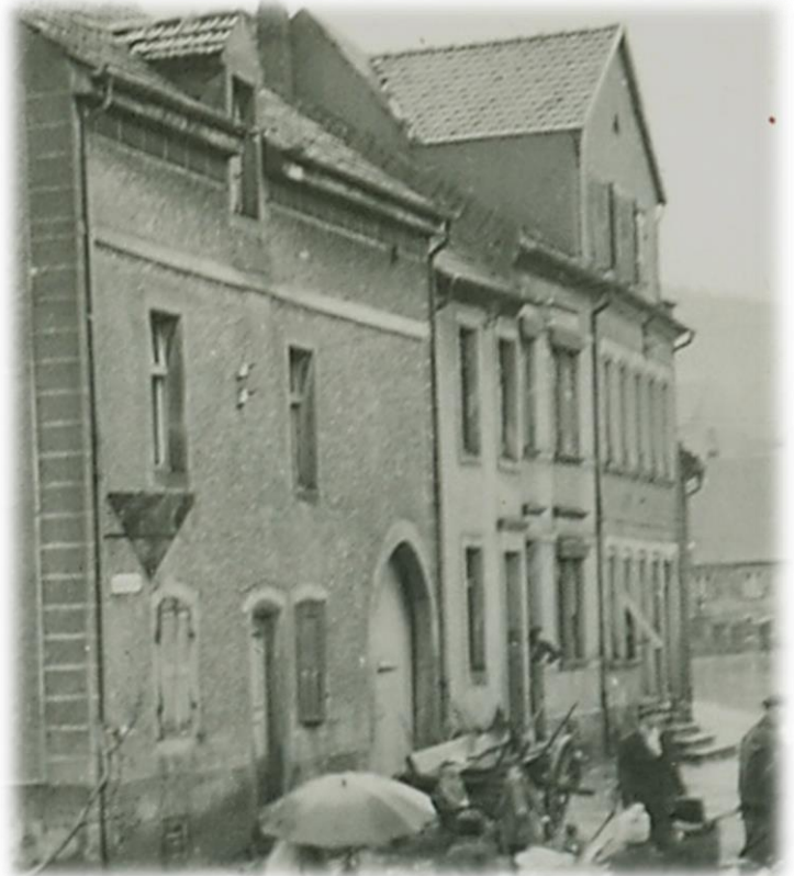
Oberdorfstraße 1935, v.l.n.r.: Oberdorfstraße 1, 3, 5 und 7. Auf diesem Bild ist zu erkennen, dass die Häuser 3 und 5 umgebaut wurden und zwei neue Traufhöhen die unterschiedlichen Dachneigungen abschließen.
