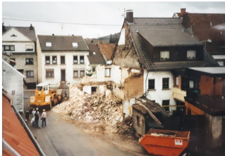
Oberdorfstraße 31, um 1988/89 beim Abriss Fotos: Josef Gebel
