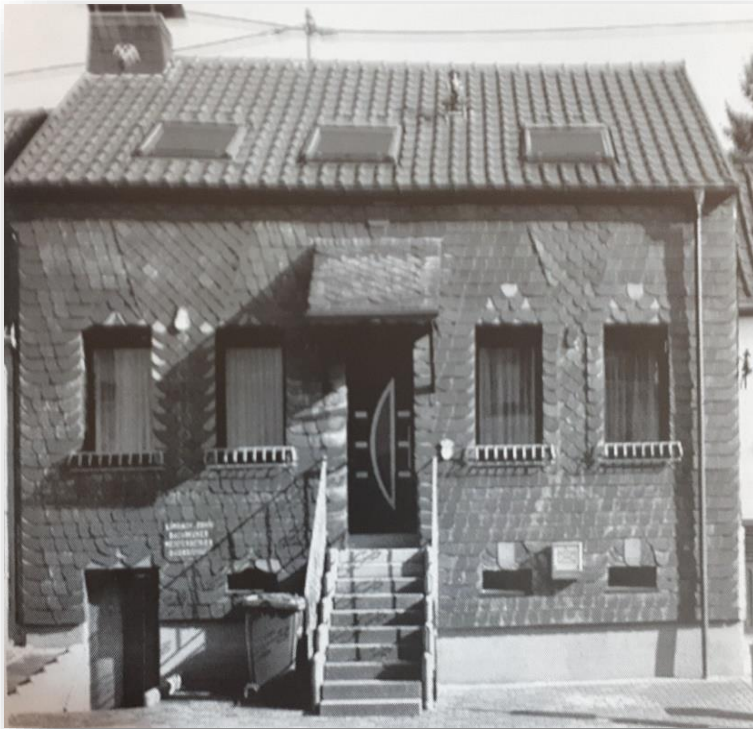
Die gesamte Sandsteinfront des Hauses wurde vor einigen Jahren mit schwarzen Schieferplatten verkleidet...“
